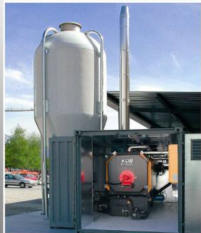
Containeranlage (Pellets)
