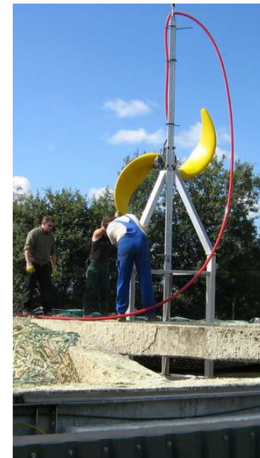
nachträgliche Montage im Fermenter
