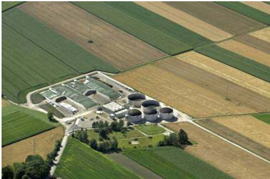
Luftbild der Anlage Pliening
